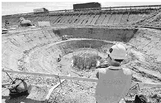
Uno dei cantieri aperti per la realizzazione della terza corsia sull'A4
