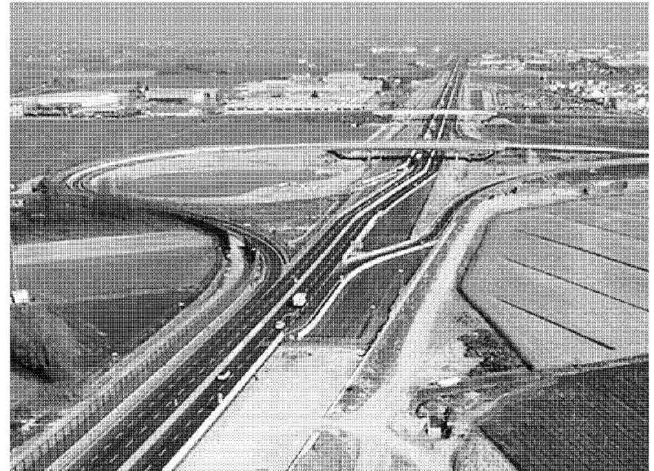
Un tratto della A4 interessato dai lavori per la realizzazione della terza corsia
