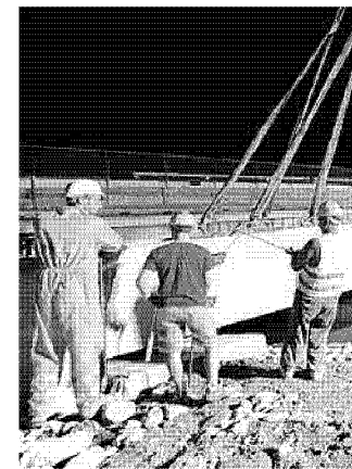
Operai in un cantiere in A4
