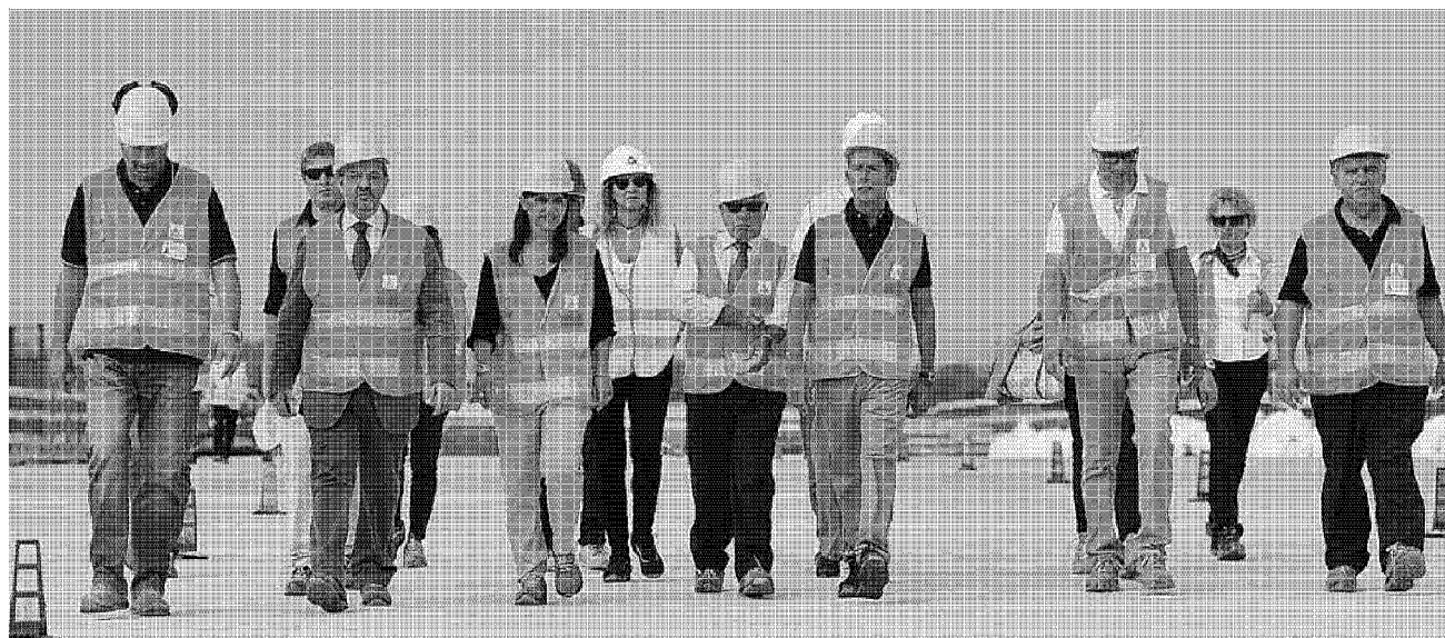
Terza da sinistra la presidente Debora Serracchiani con alla sua sinistra il presidente di Autovie Terpin durante il sopralluogo al cantiere dell'A4
