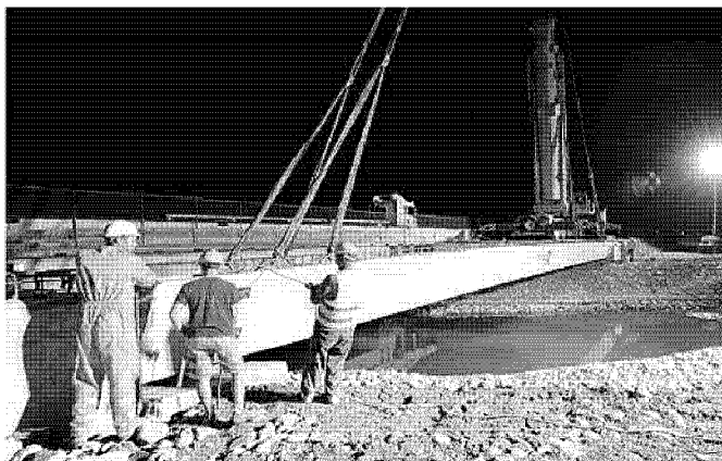
Un cantiere per la realizzazione della terza corsia
