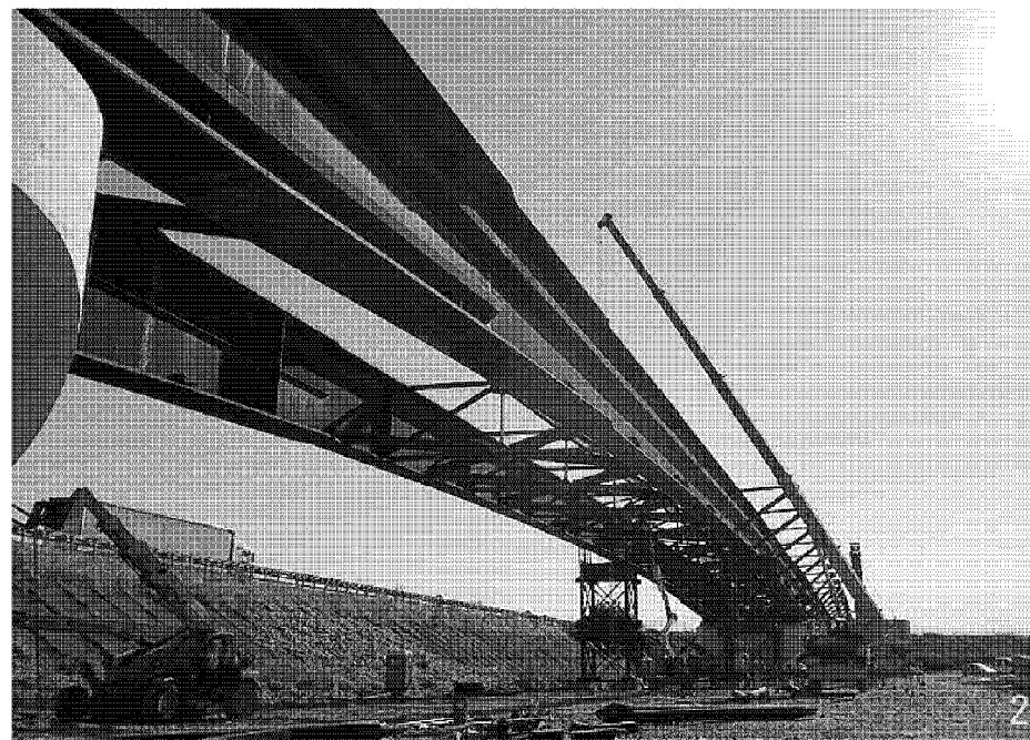
Un cantiere lungo l'autostrada A4
