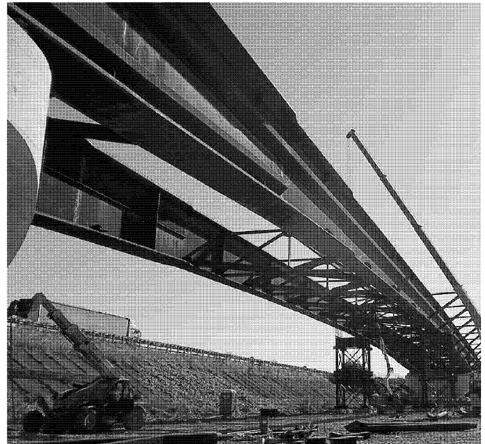
Un cantiere aperto per la realizzazione della terza corsia sulla Trieste-Venezia
