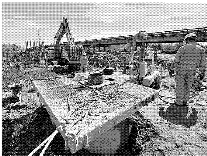
Il cantiere della terza corsia dell'autostrada A4 in Veneto
