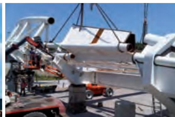
bilità, alla trave reticolare posta lungo il ciglio esterno che è invece molto rigida. Tale aspetto ha richiesto particolare attenzione durante la tesatura dei pendini, che è stata svolta in due fasi per poter posizionare l'impalcato esattamente nella posizione prevista dal progetto. L'"arcone" di entrambi i manufatti è inclinato verso l'interno della rotatoria con i pendini posti a raggiera in numero pari a quello dei traversi.
